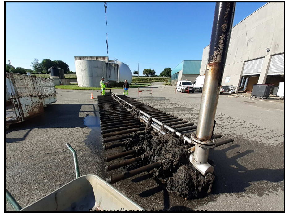
Renouvellement des membranes
